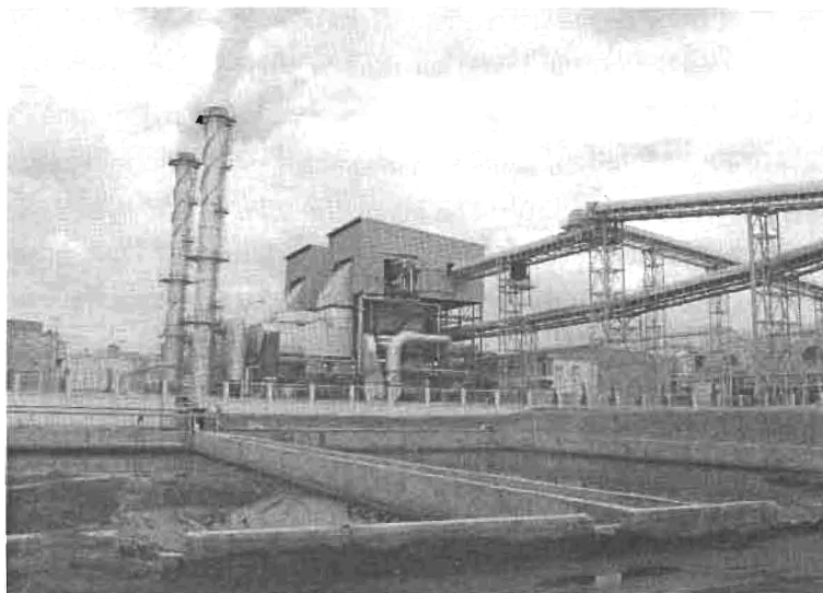
รูปที่ 1 ถ้ำซานอ้อยบริเวณบ่อพักในโรงไฟฟ้าพลังงานชีวมวล
